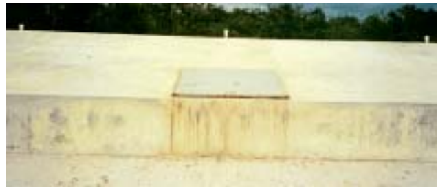
Pits de concreto
