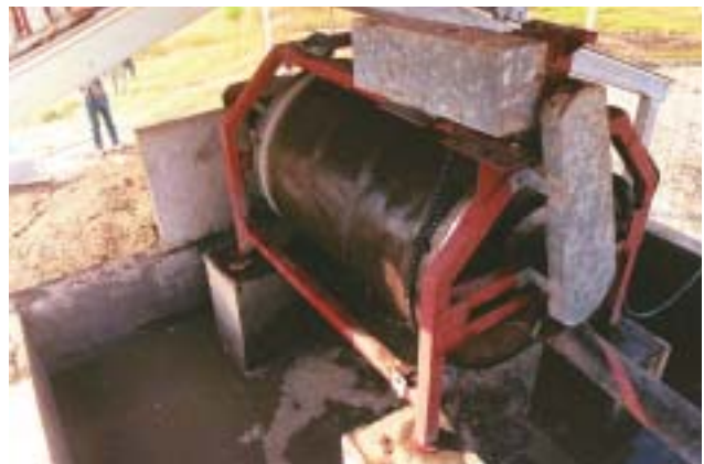
Laguna de oxidación
