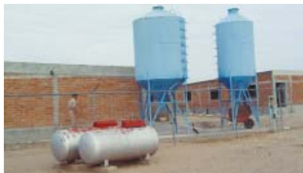
Contenedores de alimentos y abastecimiento de gas. Cercos.
